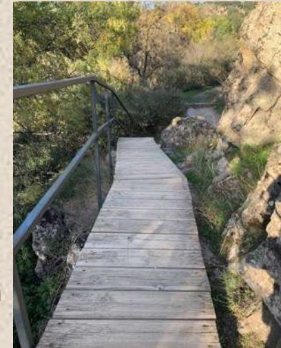
Zona de pasarelas
