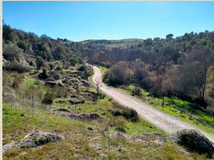
Vía de servicio sobre el canal de derivación
