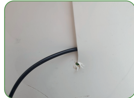
Baje con cuidado el cable hasta el agujero.
