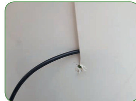
Breng het snoer voorzichtig omlaag tot het gaatje.
