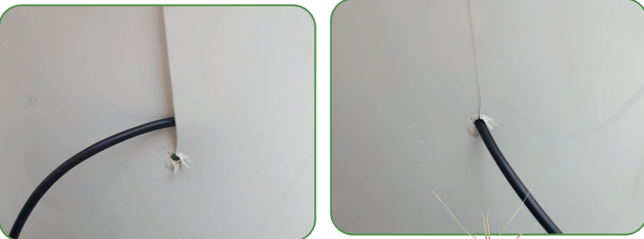
Con cautela abbassare il cavo fino al foro.
